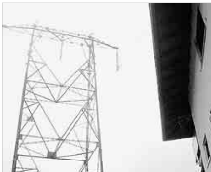
TRALICCI CICLOPICI. L'elettrodotto di Pergine, uno dei tralicci che stanno vicini alle case
