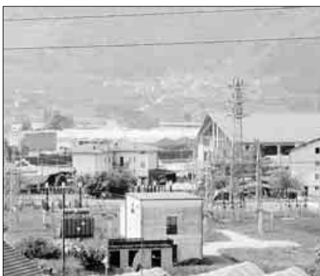
CONTESTATO. Pergine, l'elettrodotto in mezzo alle abitazioni
